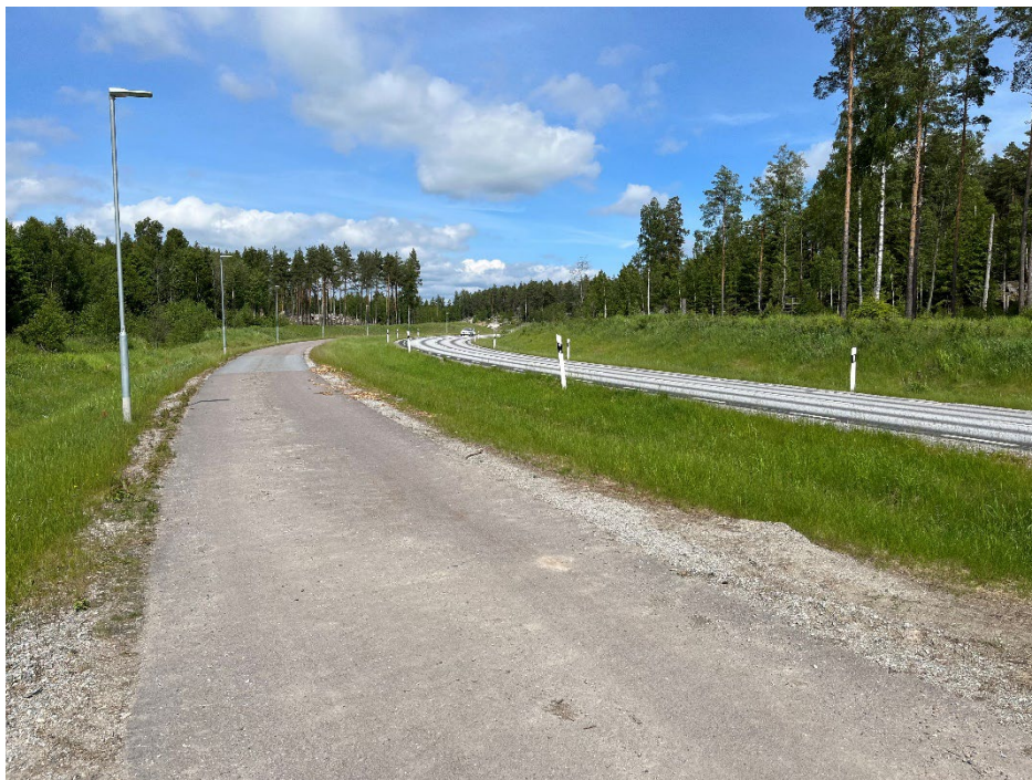
Foto: Västerås stad. Gäddeholmsvägen. Exempel på väg med en separerad gc-bana intill, samt svackdike mellan väg och gc-bana.
